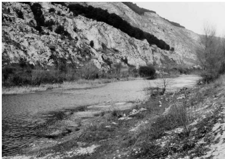
Imagen de un margen muy degradado del Ega a su paso por Cárcar, algo que se repite con frecuencia tanto en este río como en el tramo inferior del Arga.
